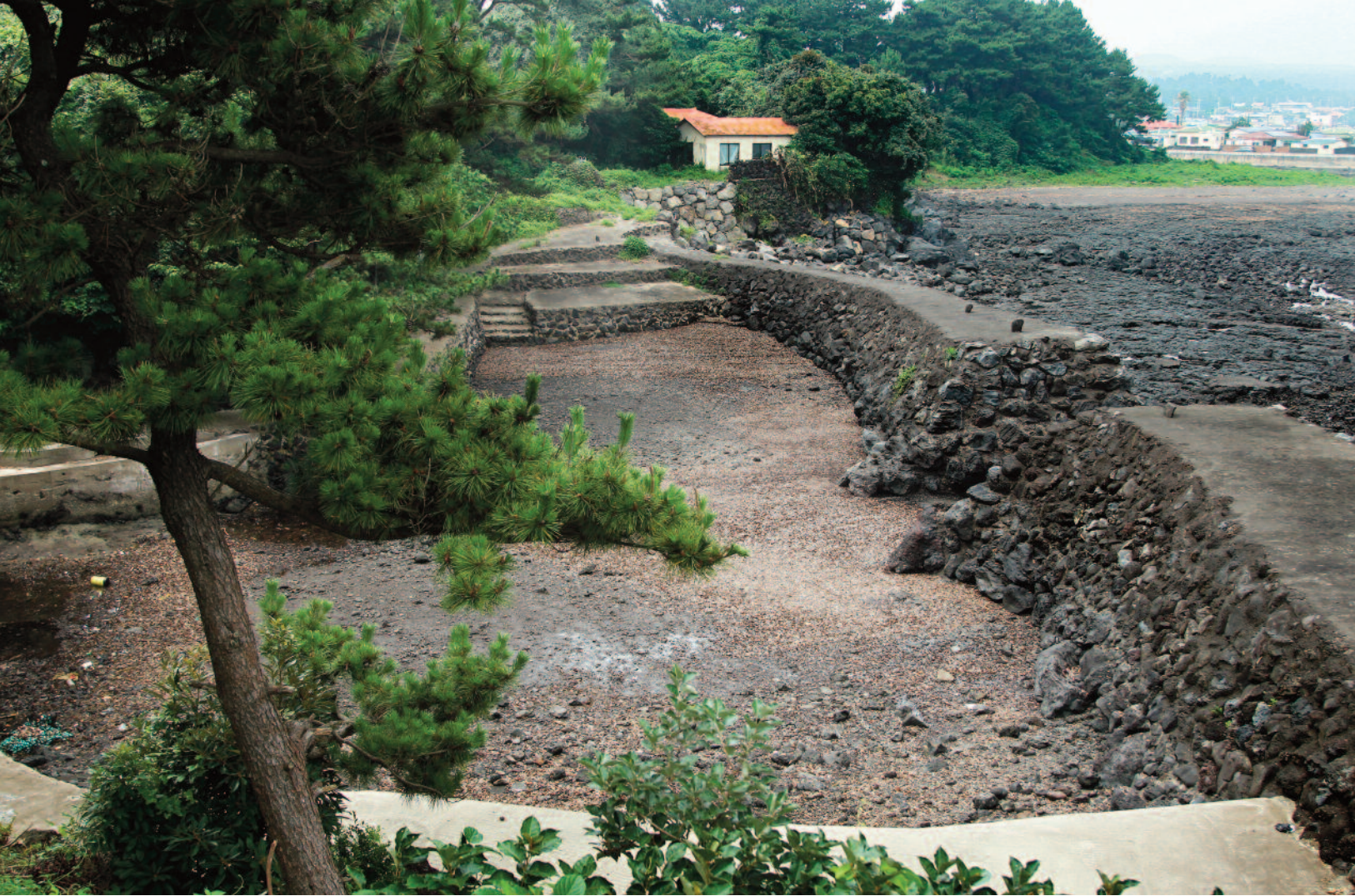
서귀포시 남원읍 하례1리의 '망장포'는 목마장의 말을 실어 나르던 조공포다. 간만의 차를 고려해 선착장에 돌계단을 쌓아 놔다. 작지만 포구의 쓰임새를 최대한 활용하고자 했던 제주 선민들의 지혜를 엿볼 수 있다. © 서재철
