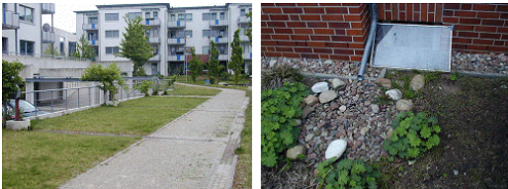
지붕 빗물 배수로 및 침투시설
