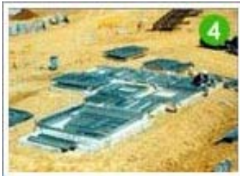
1층 및 2층 벽체 조립 완료
