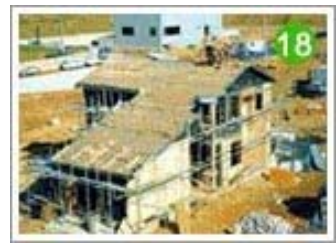
지붕 격자 설치 / 벽 합판 부착
