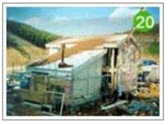
외벽 비닐사이딩 / 내부 마감 공사
