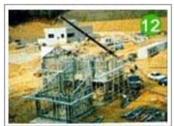
지붕 트러스 설치 시작
