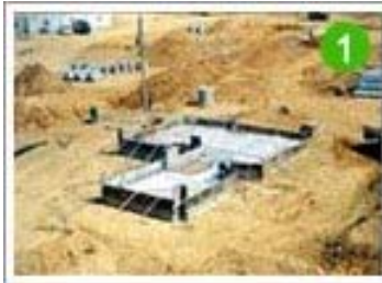
바닥 거푸집 설치
