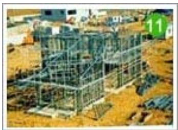
비계 설치 및 트러스조립/래프트이음
