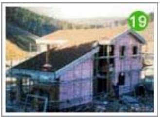
지붕기와 완료 / 외벽아이소핑크설치
