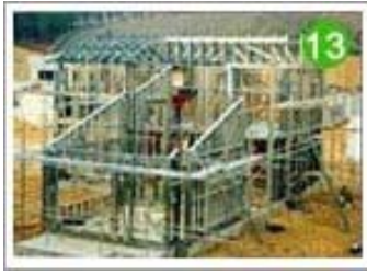
지붕 트러스 설치 완료
