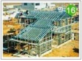
골조 마무리 작업 / 합판 부착 준비
