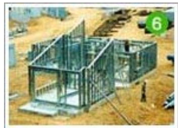
1층 보 제작 및 설치
