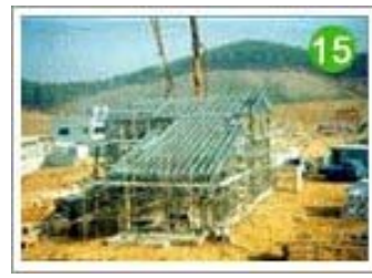
2층 바닥 경량 콘트리트 타설
