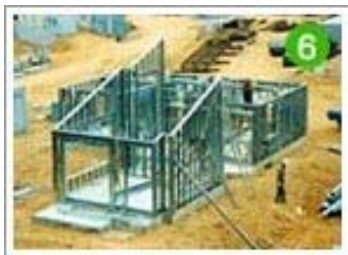
1층 벽체 설치 시작
