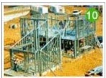
2층 벽체 설치 완료
