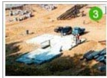
자재 반입 및 1층 벽체 조립 시작
