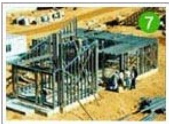
바닥 조이스트 설치
