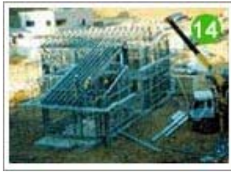
지붕 래프터 설치
