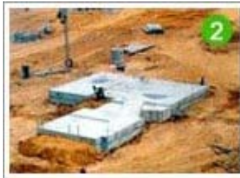
바닥 콘크리트 타설 및 양생
