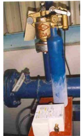
<가스 저장용기 및 기동용기 방출 사례>
