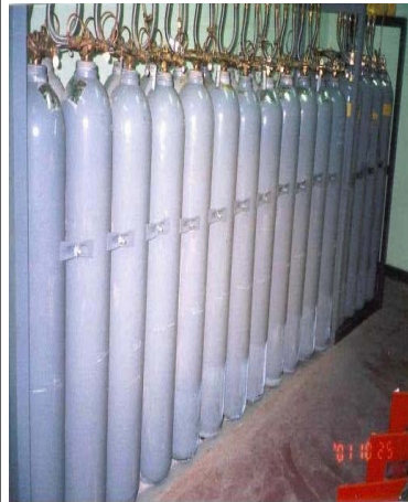
<가스 저장용기 및 기동용기 방출 사례>
