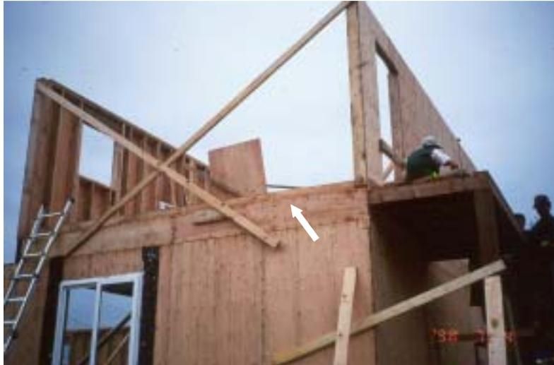
그림 42. 층식공법에서는 아래층의 천장(윗층의 바닥; 화살표 부분)이 윗층의 벽을 시공하는 작업대의 역할과 함께 이 벽을 지지하는 기능을 갖는다.
