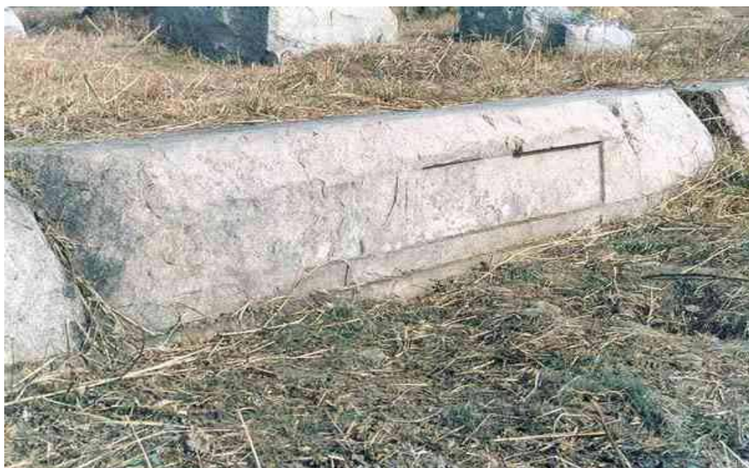
사진 5. 추정금당지 전면 석재 노출 상태
