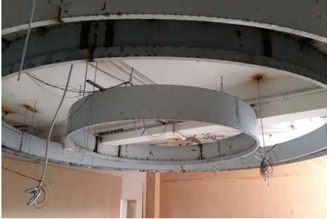
조명 공사 모습
