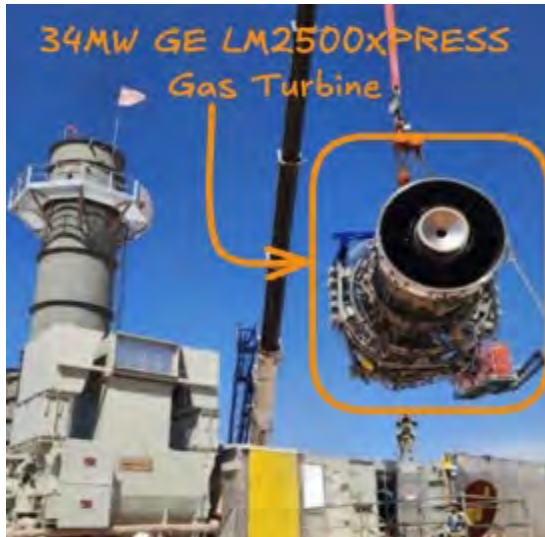
GE의 34MW 모듈형 가스터빈 설치 현장 이 장치는 신속 배치형 전력설비
