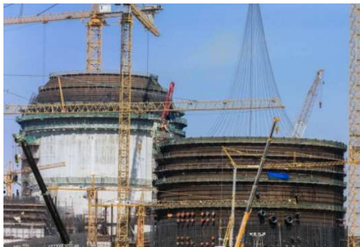
Baraka 원전 건설
