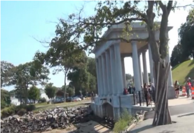
▲ 폴리머스 바윗돌 카노피(canopy) 측면 모습
