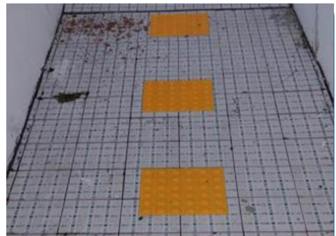
보도 블럭 설치로 안전한 도보 환경을 조성함
