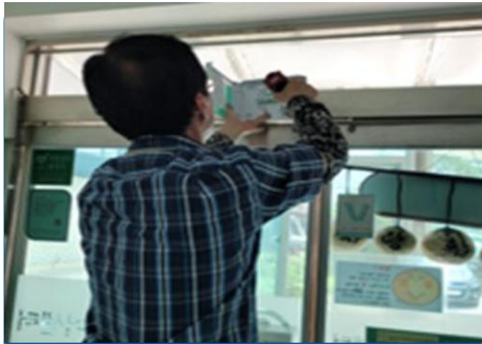
건전지 교체 주기를 놓쳐 희미했던 비상구 유도등
