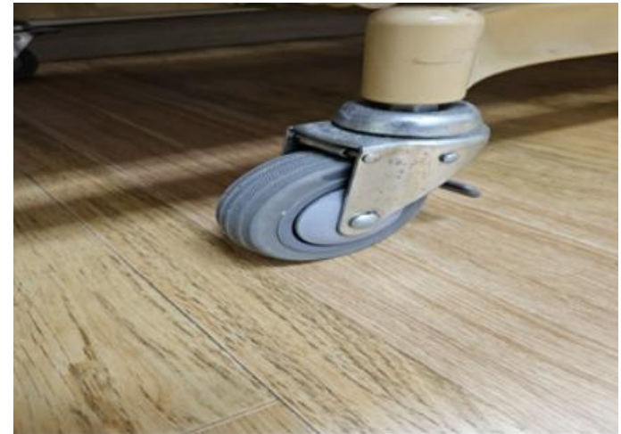
보수 공사로 안전해진 바닥
