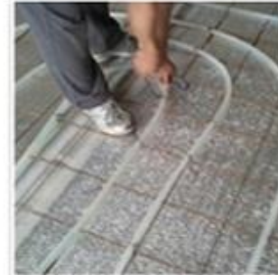
4. 초절전온수관 간격은 20~25cm 되도록 하여 설치한다. (케이블타이나 걸책선으로 와이어메쉬와 초절전온수관을 고정시킨다)
