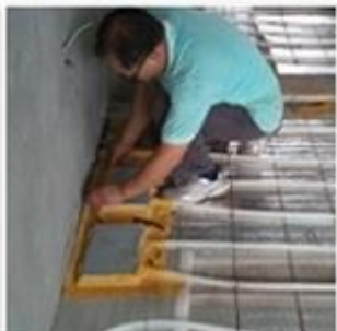
6. 전기테스트 후 점검구박스안에 물тал이 들어가지 않게 점검구를 전체적으로 막는다
