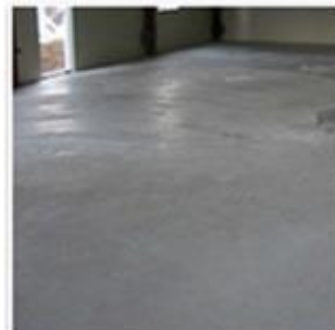
8. 콘크리트가 잘 양생이 된 뒤 최종전기테스트를 한다
