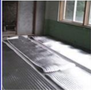
1. 단열을 위해 기초 콘크리트를 한 후 그 위에 단열재를 깔아준다
