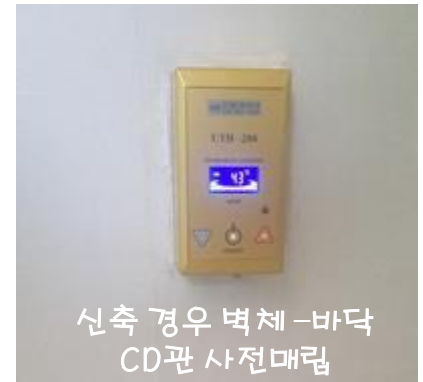
⑥ 온도조절기 (센스기) 설치
