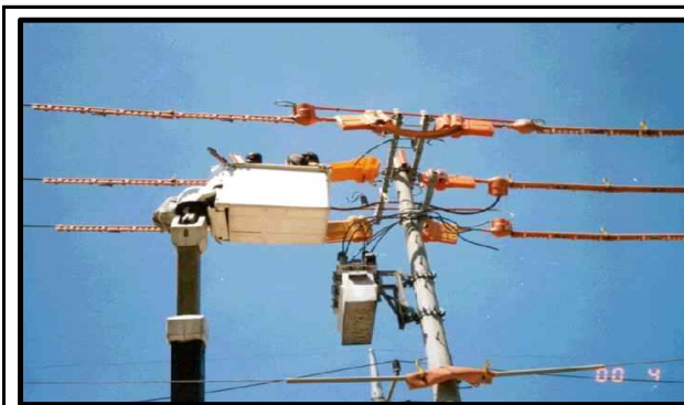
작업구간 인접총전선로에 절연방호구 설치 ○
