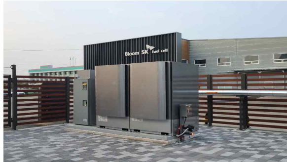
[그림 19] 블룸SK퓨얼셀 130kW급 SOEC 설비
