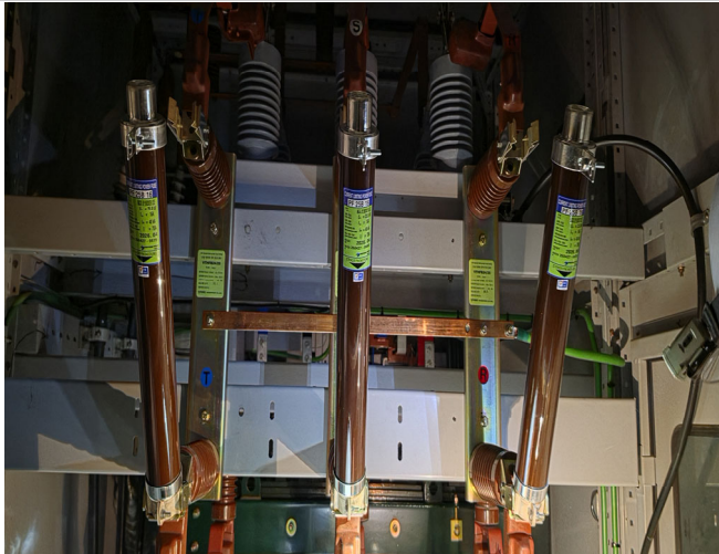
< 기 사용품 철거 후 신품 설치 >
