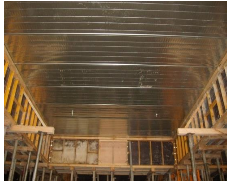
데크플레이트 시공 길이 확보
