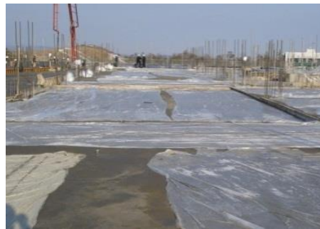
콘크리트 습윤양생 및 보양
