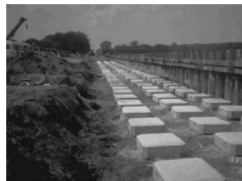
(a) 강관말뚝 시공후 말뚝캡이 설치된 모습
