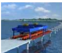
단계 5. 상부거더 Lifting
