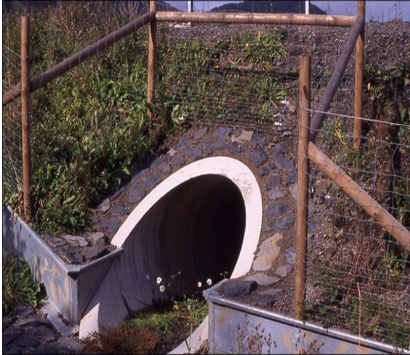
구형 파이프 암거. 도로 침입 방지턱 및 펜스 설치, 바닥에는 토양과 초본류 조성
