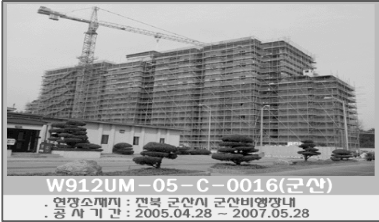
그림 IV-3 군산비행장 내 범양건영 공사현장
